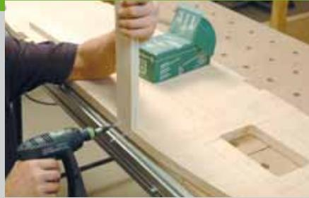
diese mit Spax (3,5 x 40) von oben fest. Wenn Sie die Kiste später deckend lackieren möchten, sollten Sie die Schrauben ca. 1 mm tief im Holz versenken, um Platz für Spachtelmasse zu schaffen. Schleifen Sie mögliche Unebenheiten mit einem Exzenterschleifer und Schleifpapier Körnung P 80 weg. Bohren Sie nun alle Löcher, die für die Befestigung der Fahrwerksteile benötigt
